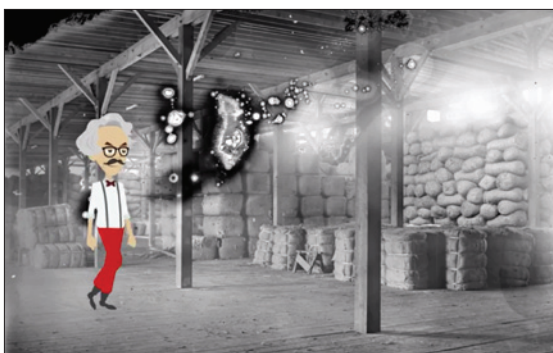
VASEMMALLA Pysäytyskuva Gatesheadissa sijaitsevan varaston omistajaa Edward Moorea käsittelystä filmistä. Tynesiden suuren tulipalon on raportoitu alkaneen tästä varastosta
