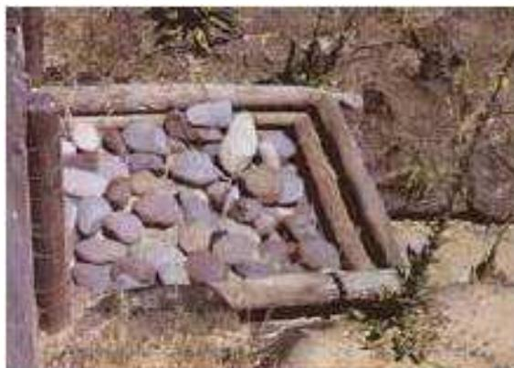
Figura 3.8 - Vista lateral de un dissipador construido con postes de pino impregnado y bolones de río.
