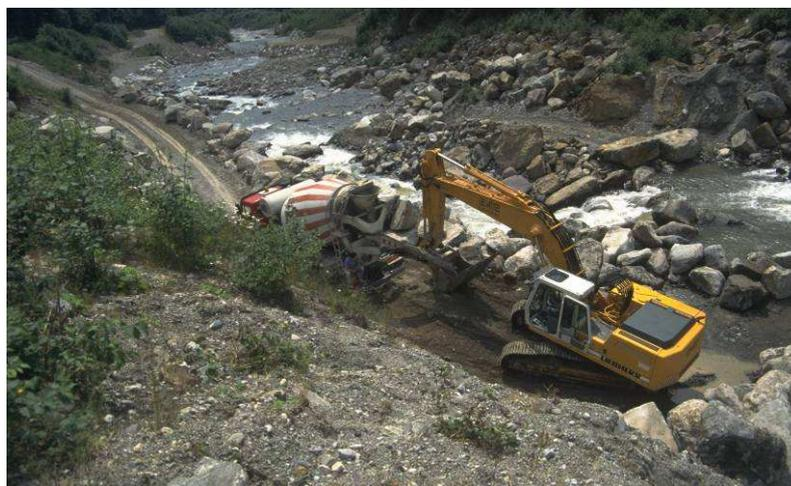
Figura. 2.9 - El hormigón es transportado hasta la obra por medio de un mixer (torrente Maso di Spinelle, Trento) (Fuente: Lenzi y *Otros*, 2000).
