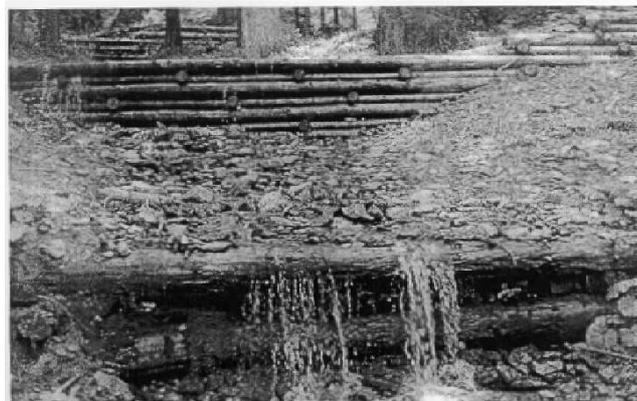
**Figura 3.34 - Dique con cajón con el paramento aguas abajo tamponado con madera.**
