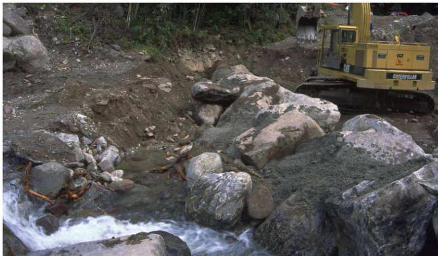
Figura 2.11 - El hormigón es colocado en la excavación aguas arriba de la fila de los bloques (torrente Maso di Spinelle, Trento) (Fuente: Lenzi y *Otros*, 2000).
