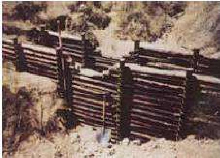
**Figura 3.4 - Vista en primer plano de diques de madera con reforzamiento posterior de sacos y relleno de tierra. (Fuente: Aznar Fabra, 2003)**
