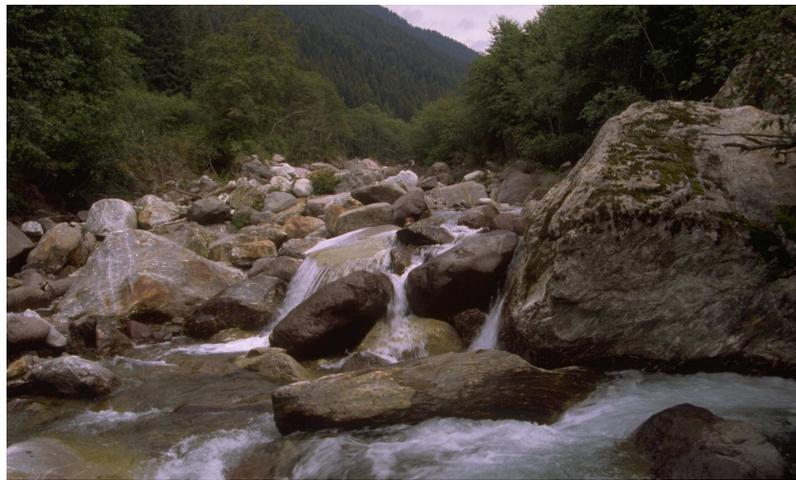
Figura 2.6 - Ejemplo de un tramo de lecho en el cual se ha intervenido con la construcción de *step* en seco (torrente Maso di Spinelle, Trento) (Fuente: Lenzi y Otros, 2000).
