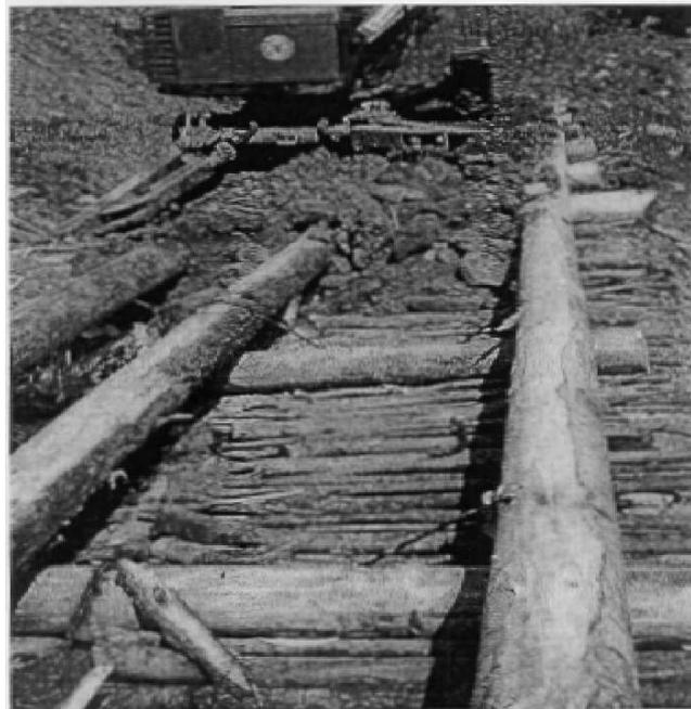
**Figura 3.33 - Utilización de traviesas en una obra de cajón con doble pared.**
