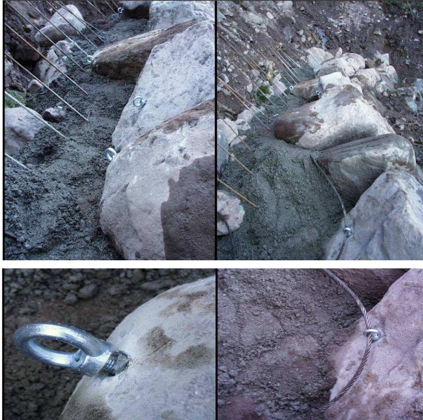
Figura 2.2 - Obra transversal con estructura agua arriba de hormigón y paramento aguas abajo constituido por bloques ciclópeos: detalle sobre la modalidad de anclaje de los bloques a la estructura (Fuente: Lenzi y *Otros*, 2000).
