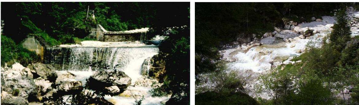
Figura 2.3 – Situación antes (izquierda) y después (derecha) de la sustitución de las obras de hormigón por obras transversales en bloques (torrente Canali, Trento) (Fuente: Lenzi y *Otros*, 2000).
