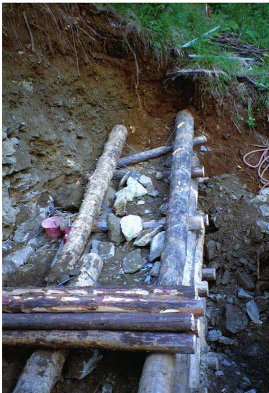
Figura 3.9 - Dique a cajón en fase de construcción. (Fuente: Lenzi y Otros, 2000).
