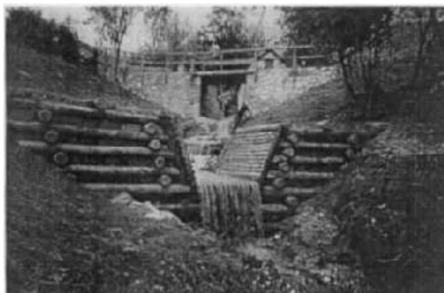
**Figura 3.35 - Dique con cajón con el paramento aguas abajo tamponado con piedras.**
