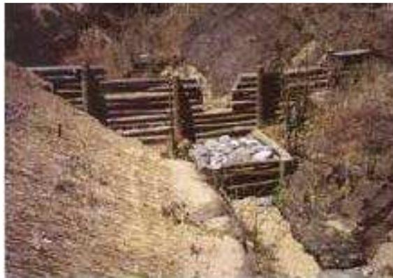
Figura 3.7 - Vista general de diques de postes de madera con dissipador (1 x 0,6 m).
