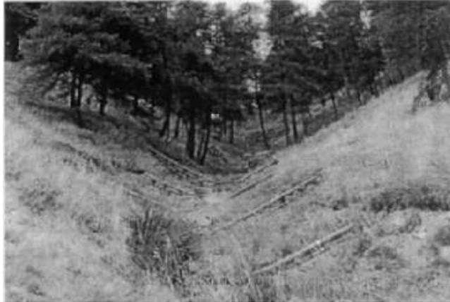
**Figura 3.38 - Consolidación del cauce: diques con cajón y con vertedero en forma de cola de golondrina. (Fuente: Andrich, D'Agostino 2000).**
