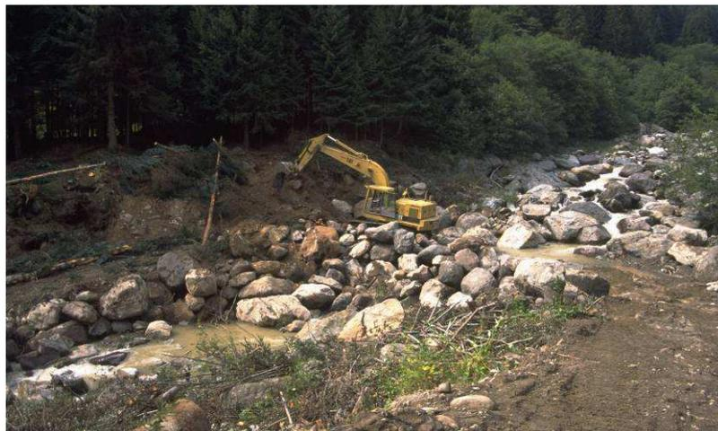
Figura 2.8 - Fases iniciales de la construcción de un *step* artificial con bloques simplemente consolidado con hormigón. La excavadora está abriendo una fisura sobre la ladera (torrente Maso di Spinelle, Trento) (Fuente: Lenzi y *Otros*, 2000).
