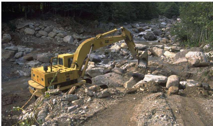
Figura 2.12 - La trinchera aguas arriba es llenada con bloques de menores dimensiones y con tierra (torrente Maso di Spinelle, Trento) (Fuente: Lenzi y *Otros*, 2000).
