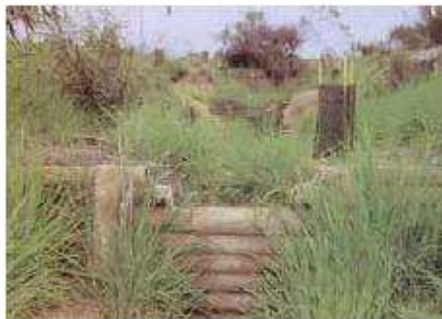
**Figura 3.3 - Diques de postes de madera en áreas de cárcavas activas en fase de estabilización.**
