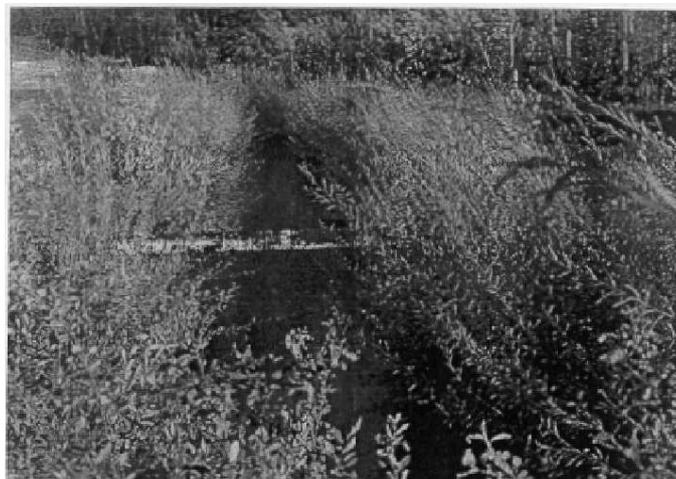
**Figura 3.28 - Corrección de riberas con una empalizada después de un año de su construcción. (Rio Sacco, Val Venosta Bz)**
