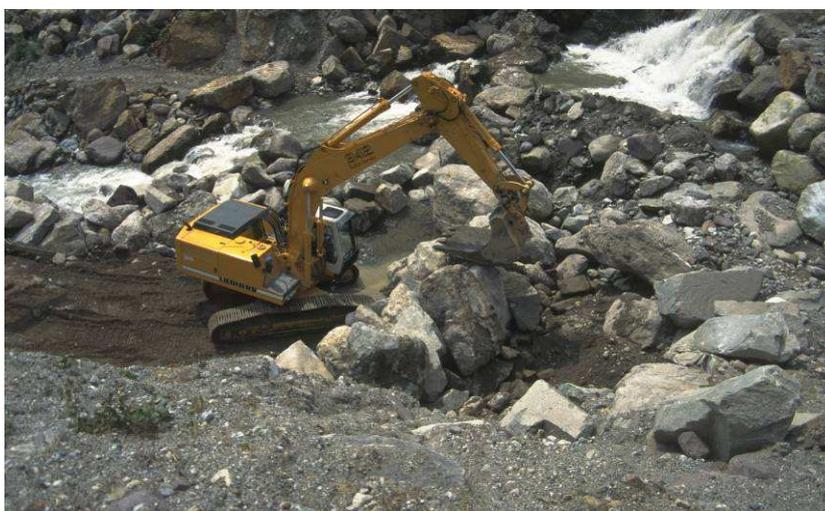
Figura 2.10 - Inserción del hormigón entre los agujeros presentes entre un bloque y otro (torrente Maso di Spinelle, Trento) (Fuente: Lenzi y *Otros*, 2000).
