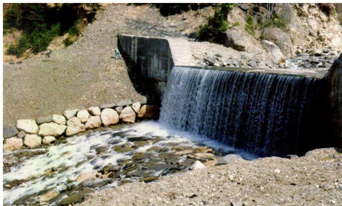
Figura 2.5 - Rampa de bloques realizada agua abajo de un dique de consolidación (torrente Fiorentina) (Fuente: Lenzi y *Otros*, 2000).
