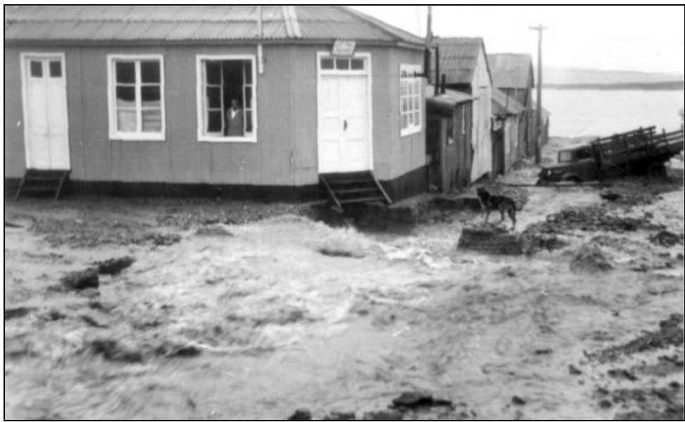
Figura 3.11.- Ushuaia, afectada por el evento de 1954
