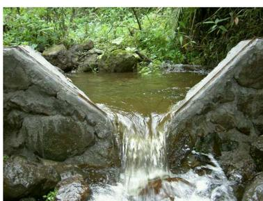
Figura 15.- Sección de control.- Vertedero triangular instalado en Lise
