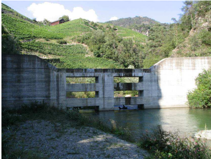
Figura 3.11 - Dique abierto a ventanas múltiples en el Fiume Isarco (Alto Adige).
