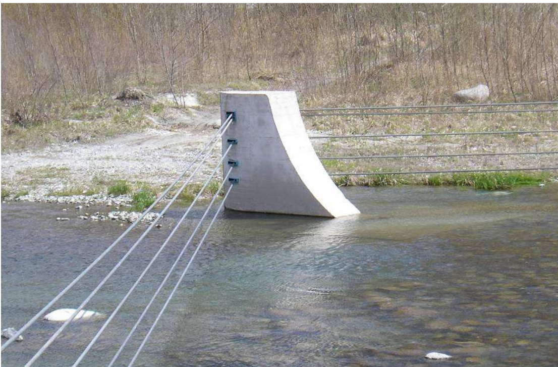
Figura 4.26 - Contrafuerte central del dique cableado en el T. Sarca (Bocenago-Italia).
