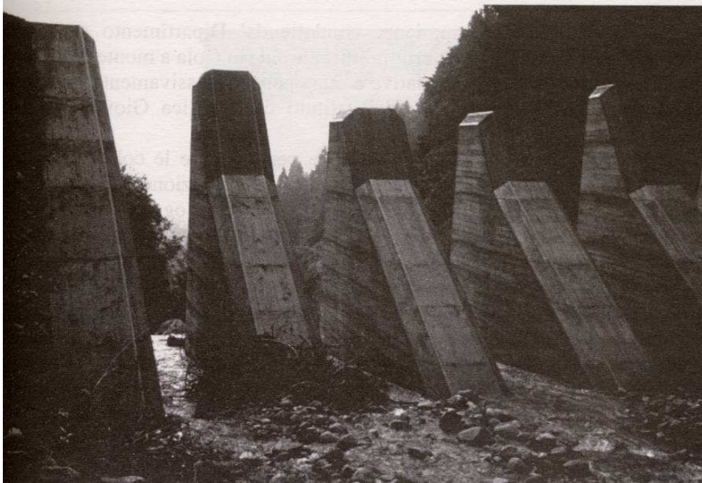
Figura 4.7 - Dique filtrante con función de detención de la colada detrítica (Torrente Chieppena, Trento), (Fuente: Ferro y Otros, 2004) .
