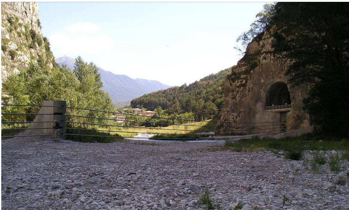
Figura 4.29 - Dique cableado en el Río Sarca, visto desde aguas arriba (Ponte delle Sarche-Italia).
