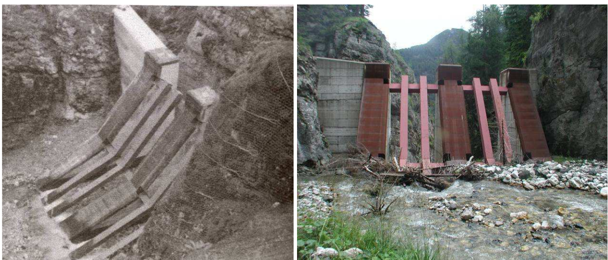
Figura 4.9 - Dique filtrante en Val Duron antes y después de una crecida (Fuente: Ferro y Otros, 2004).
