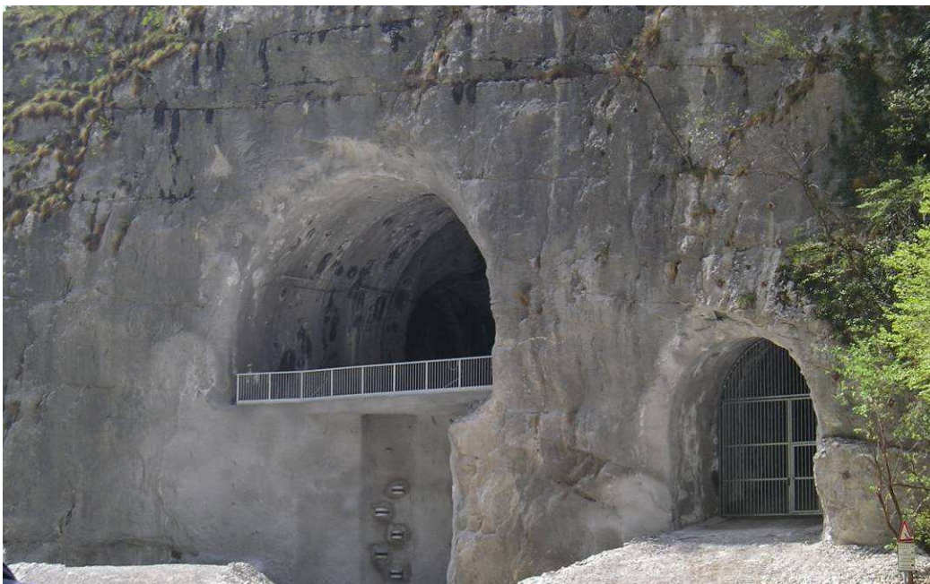
Figura 4.33 - Túnel lateral excavado en roca en la margen derecha para el mantenimiento de la estructura (Ponte delle Sarche-Italia).
