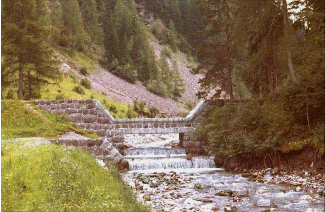
Figura 3.9 - Primer dique a ventana en Italia.
