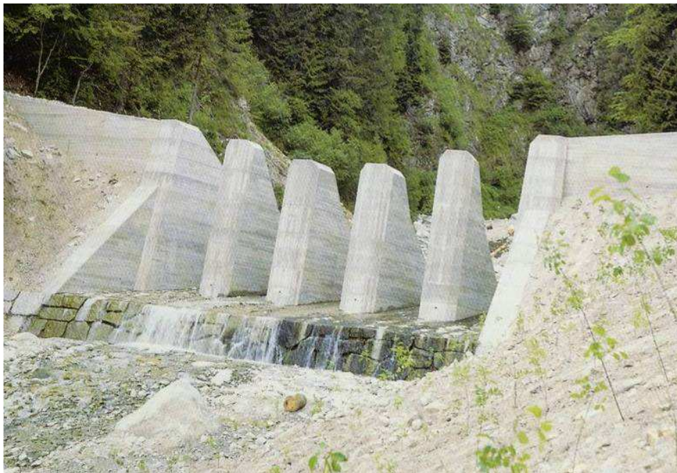
Figura 4.6 - Torrente Chiepena; dique filtrante construido en la parte alta de la cuenca en el 1992 (Fuente: Cerato, 1999).
