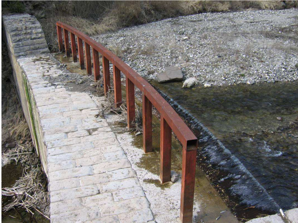
Figura 3.13 – Dique abierto a rastrillo con piezas verticales en el Torrente Fiorentina (Caprile, Region Veneto).
