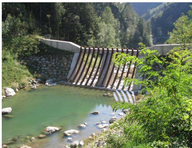
Figura 4.14 – Dique selectivo con reja y filtro inclinado (Torrente Isarco, Alto Adige).
