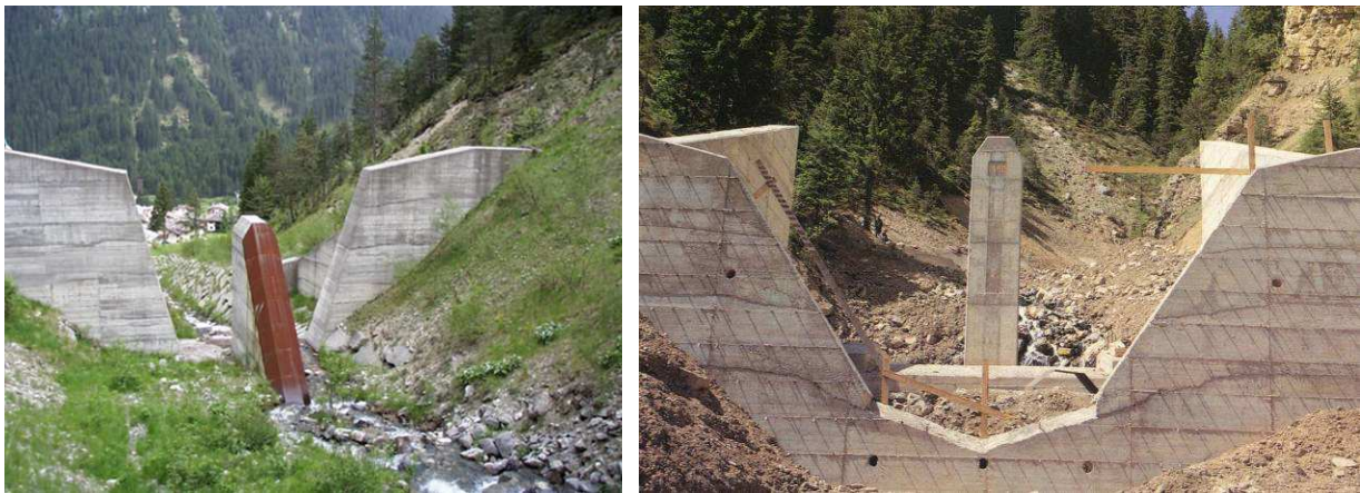
Figura 4.5 – Ejemplo de obra filtrante con un cuneo rompe-colada, visto desde aguas arriba y desde aguas abajo (Fuente: Provincia Autónoma de Trento, 1991).
