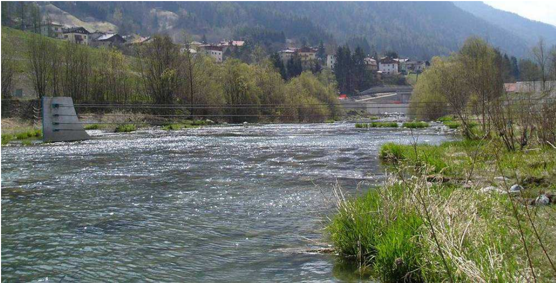
Figura 4.25 - Dique abierto cableado en el río Sarca (Bocenago-Italia).
