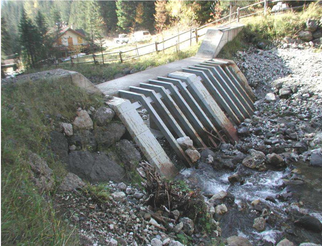
Figura 4.11 - Dique abierto selectivo a triple inclinación.
