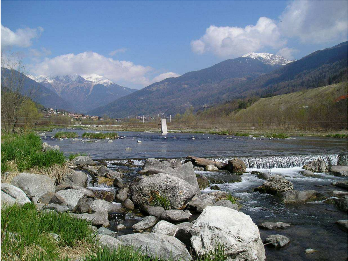
Figura 4.27 - Dique cableado y umbral de fondo visto desde aguas abajo, T. Sarca (Bocenago-Italia).
