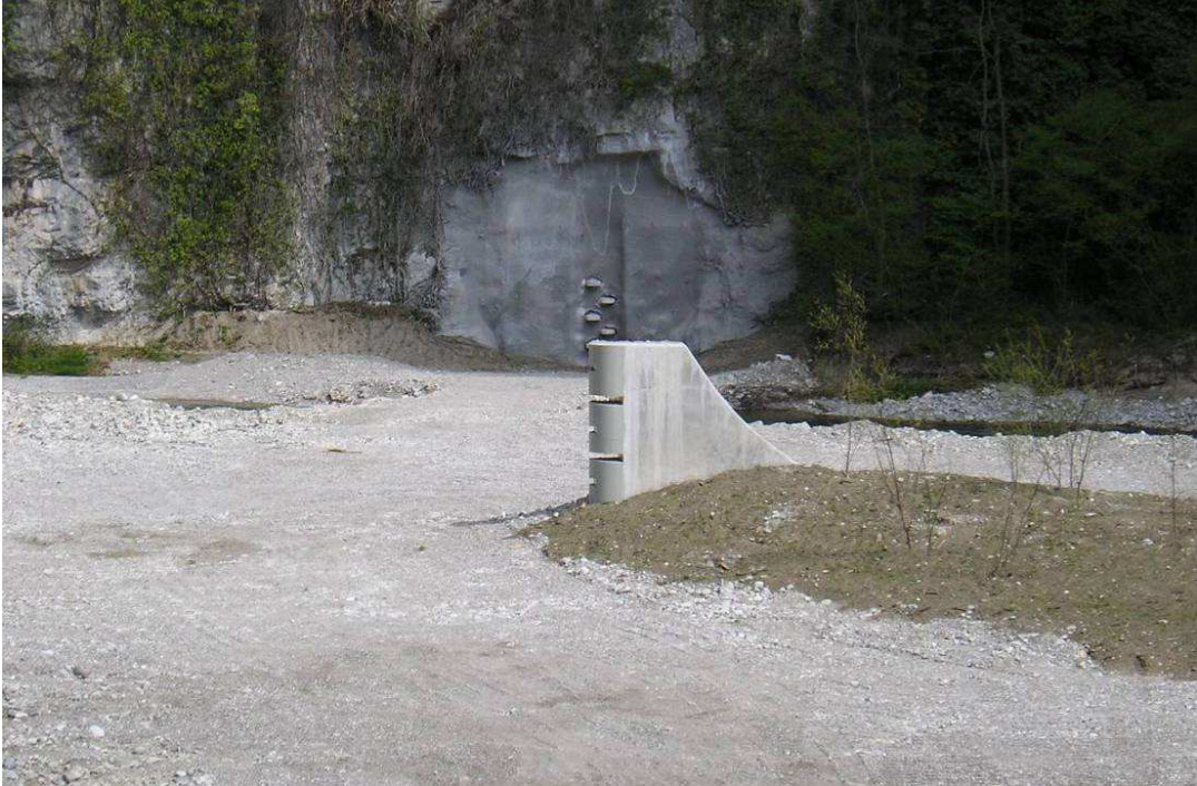
Figura 4.30 - Dique cableado durante la fase de construcción (Ponte delle Sarche-Italia).
