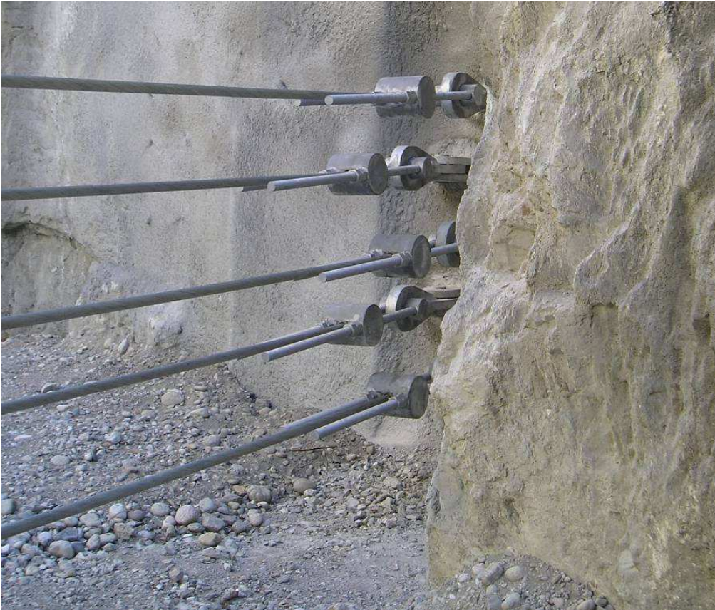
Figura 4.32 - Anclajes laterales de los cables en la pared rocosa (Ponte delle Sarche-Italia).
