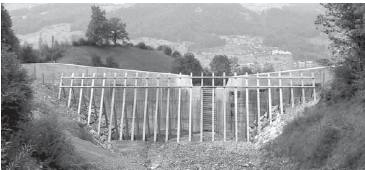
Figura 4.43 - Obra para la retención de la madera utilizada en proximidad de un dique ya existente en el torrente Edisriedbach cerca de Sachseln (Cantón Obwalden) (Bezzola y Otros, 2004).
