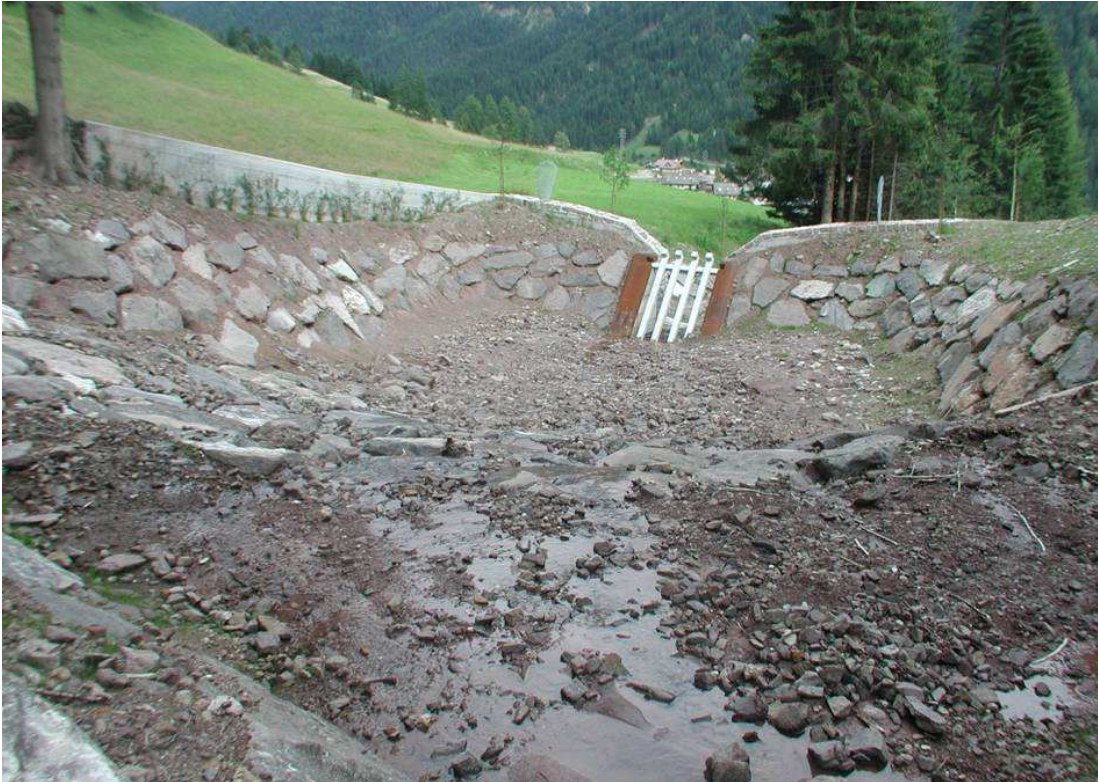
Figura 4.15 – Dique selectivo con filtro inclinado y plaza de deposito aguas arriba (Trento).
