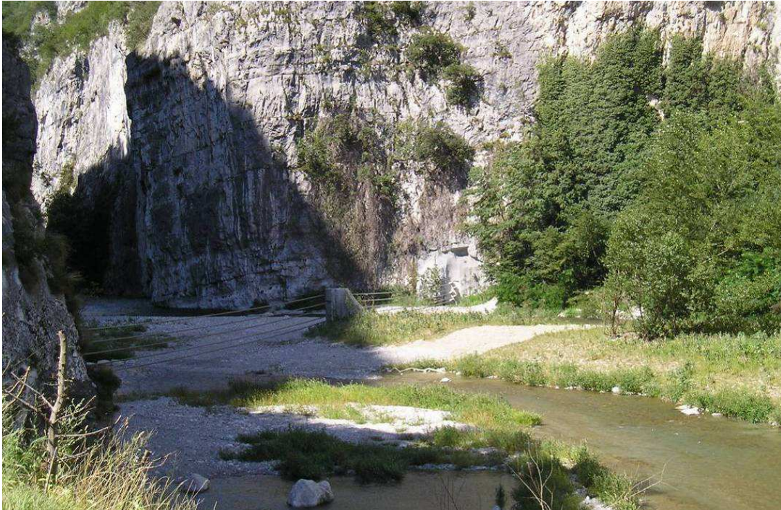
Figura 4.28 - Dique cableado en el Río Sarca, visto desde aguas abajo (Ponte delle Sarche-Italia).
