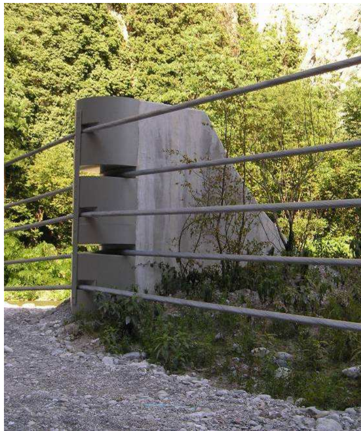
Figura 4.31 - Contrafuerte central del dique cableado (Ponte delle Sarche-Italia).
