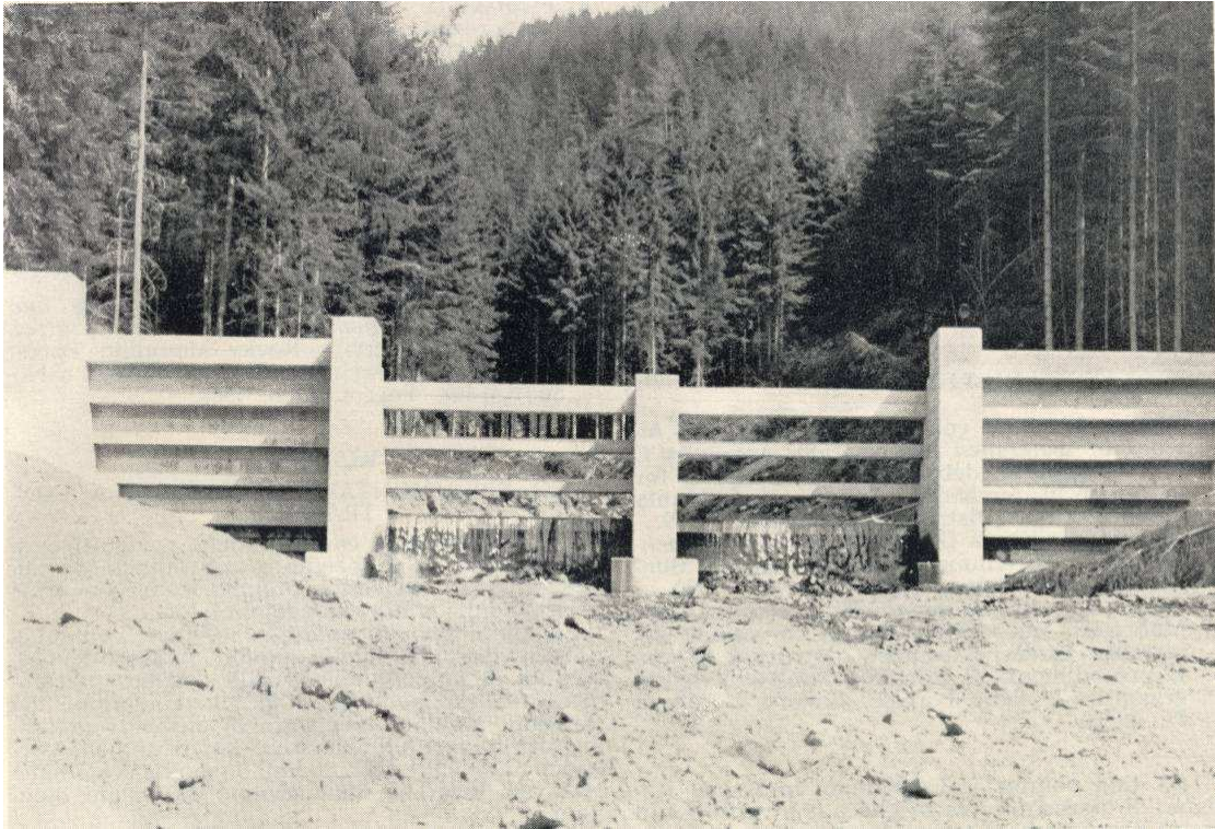
Figura 4.1 - Dique con contrafuertes (Fattorelli, 1972), visto desde aguas abajo después del montaje.
