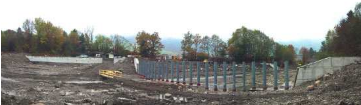
Figura 4.51 - Combinación de dispositivos para la retención de la madera en el río Gurbe ( trashrack y downflow baffle ) ( http://www.vaw.ethz.ch ).
