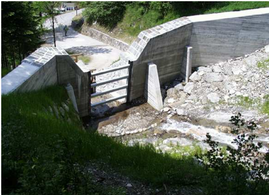
Figura 3.12 - Dique abierto con rejas horizontales (Río Civerton, Trento).
